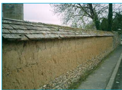
Mur en terre crue, soubassement silex. Broué.
