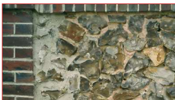
Maçonnerie de brique et silex.
