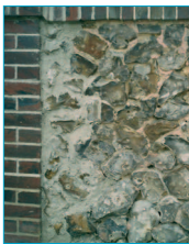
Mur en silex et chaîne en brique.
