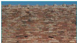
Le faitage des toitures en tuile
